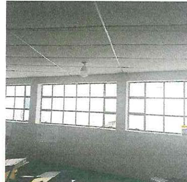
Foto 2: Sustitución de ventanas de metal por ventanas de PVC.
